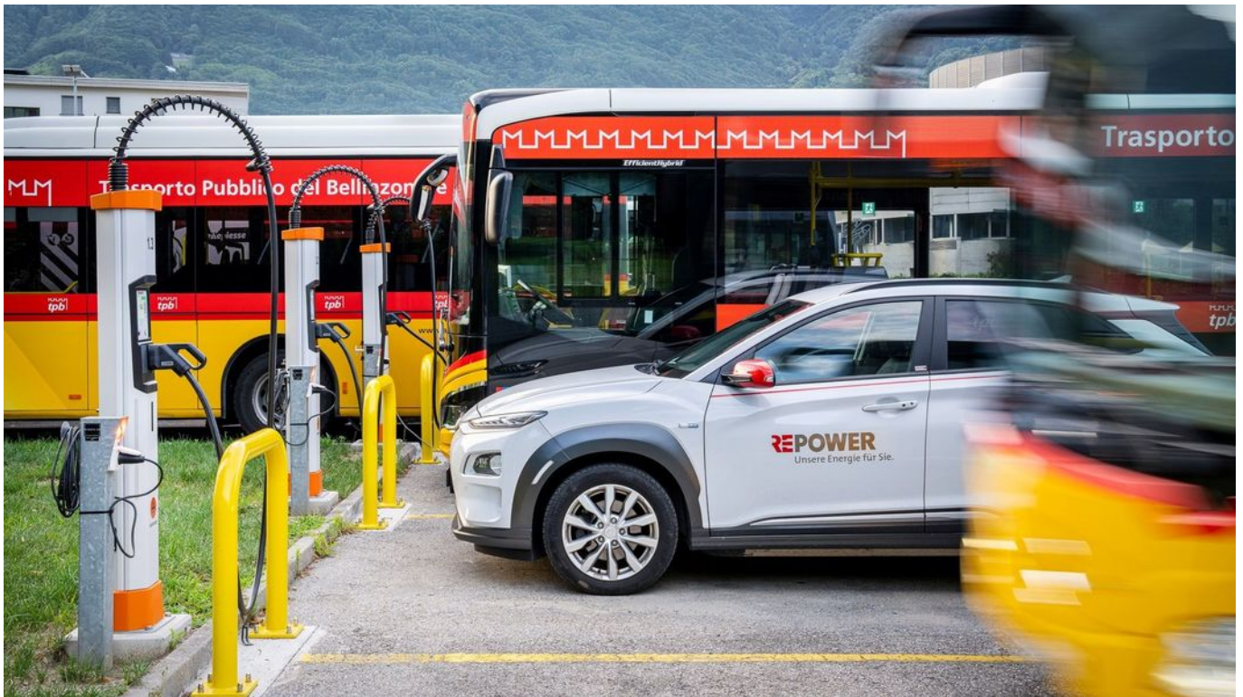
Su incarico di AutoPostale Repower ha dotato il deposito di Bellinzona con infrastruttura di ricarica DC di ultima generazione.
