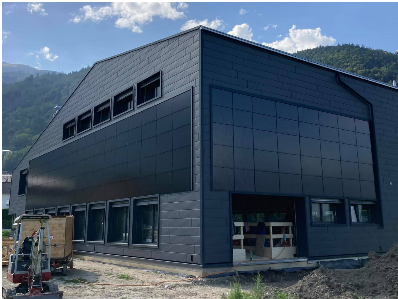
Auf dem Dach und an der Fassade der neuen Schwing- und Sporthalle Rüfeli in Untervaz wird Strom produziert - mit Photovoltaikanlagen von Repower.
