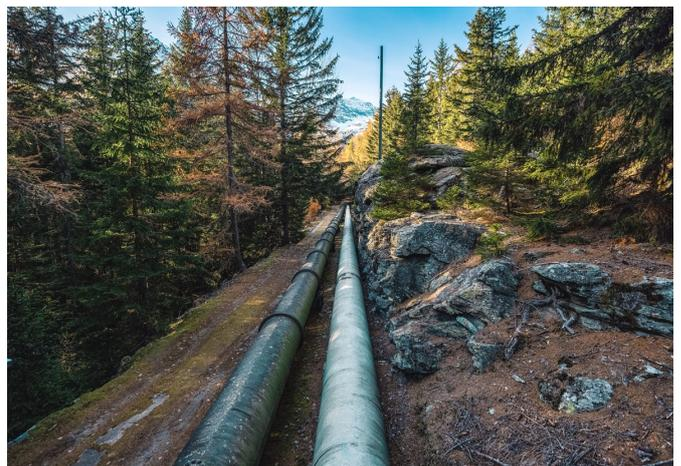
L'edificio della centrale verrà quasi completamente svuotato e gli attuali due tubi in pressione di Balbalera verranno sostituiti da un'unica condotta forzata più grande.
