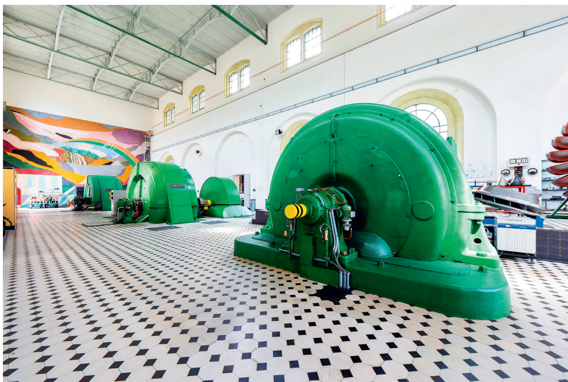
La centrale idroelettrica di Robbia
