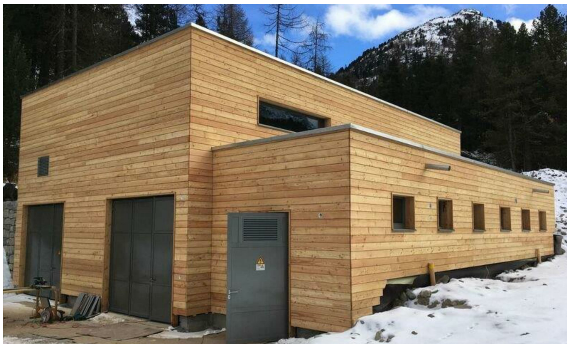
La Centrale di Morteratsch, in Engadina, appena termina.
